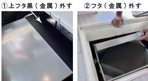
STEP/ 05 取り出した後、熱交換素子・ケース内部の埃を掃除機などで取ってください
